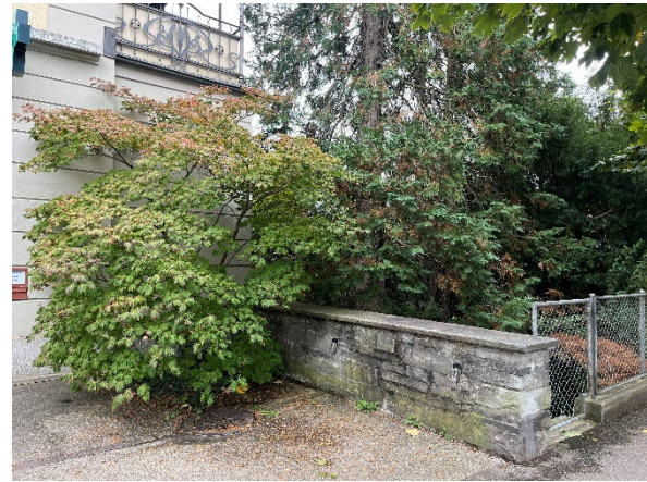
Abbildung 7: Randbereich mit Mauer zur potenziellen informellen Nutzung. Quelle: eigene Aufnahme vom 06.10.2025
