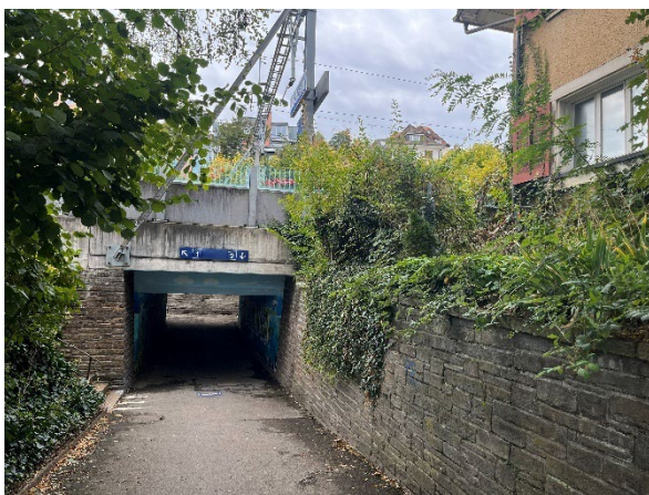
Abbildung 10: Bahnunterführung und Mauer der Bahnhofstrasse 12. Quelle: eigene Aufnahme vom 06.10.2025.
